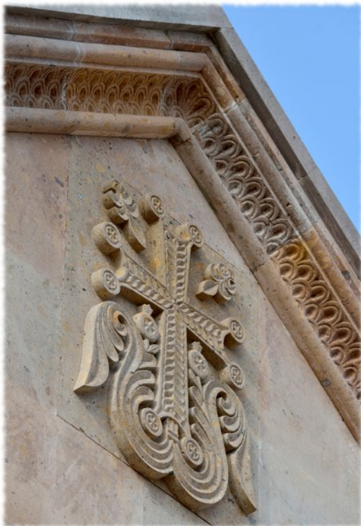
Dettaglio delle decorazioni di facciata scolpite direttamente sui blocchi lasciati sporgenti in fase di costruzione.
