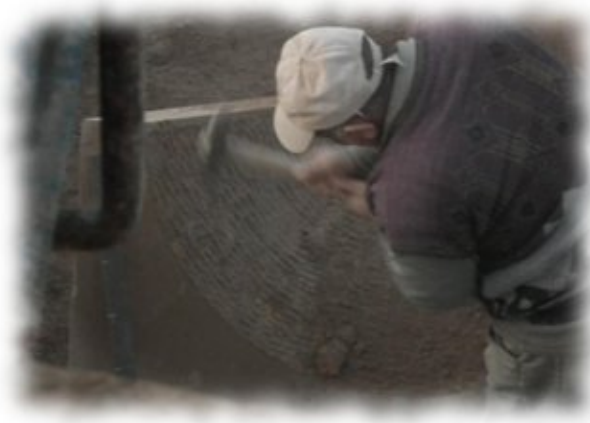
Il tagliapietre scolpisce a mano la uno dei pennacchi del tamburo ottagonale.
