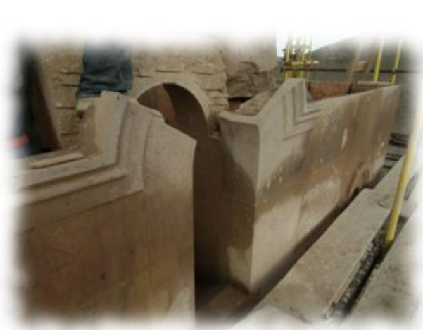
Realizzazione di una finestra.
