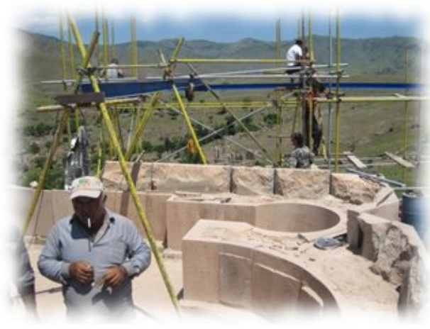
Tecnica dell' emplekton nel cantiere della nuova Chiesa progettata dall'arch. Atayants.
