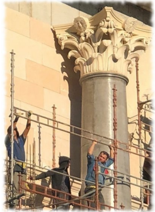
La colonna a posa ultimata..
