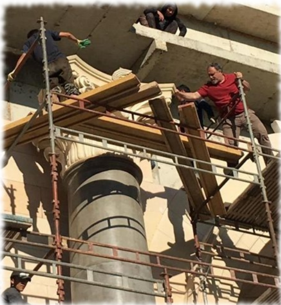
Maxim Atayants sovrintende alla posa di un capitello su una delle colonne di facciata.
