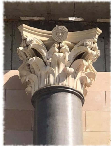
Nuova Cattedrale di San Pietroburgo. Dettaglio di un capitello appena inserito su una delle colonne di facciata.
