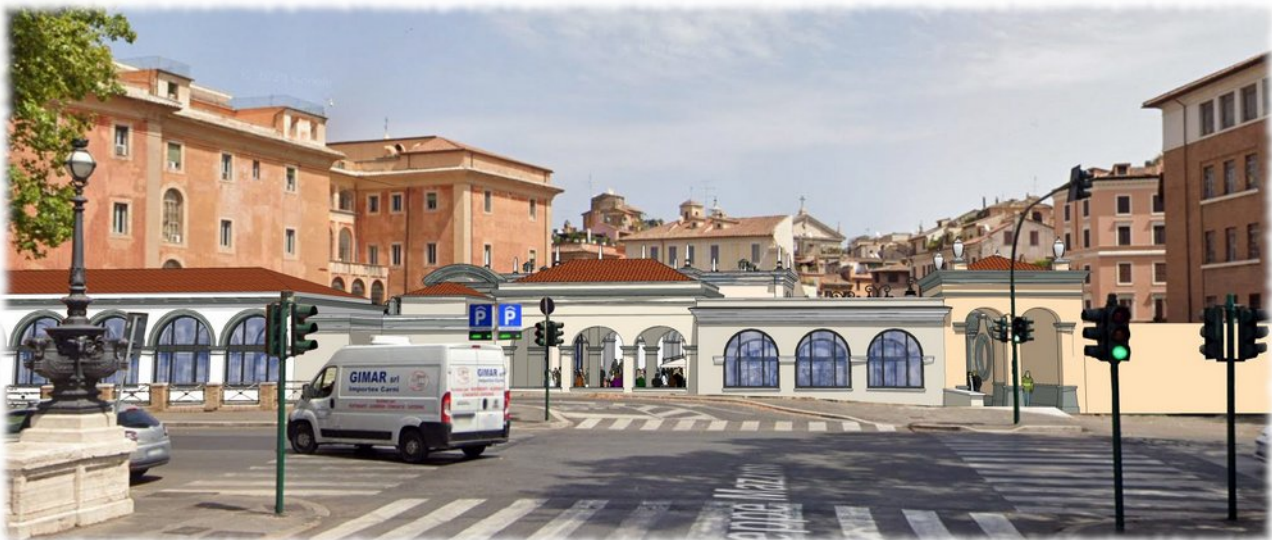
Vista da Ponte Mazzini delle strutture poste a mascheramento e coronamento del volume del parcheggio
