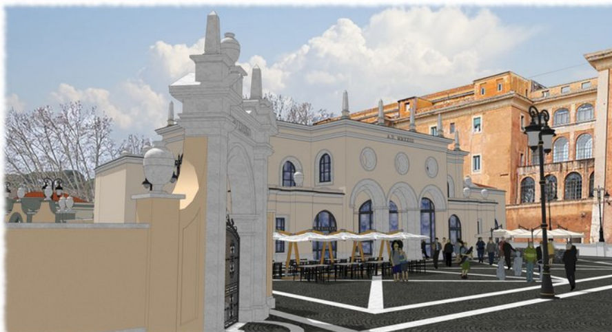
L'ingresso al Liceo Virgilio e, sulla Piazza, la Loggia che ospita attività per la ristorazione.
