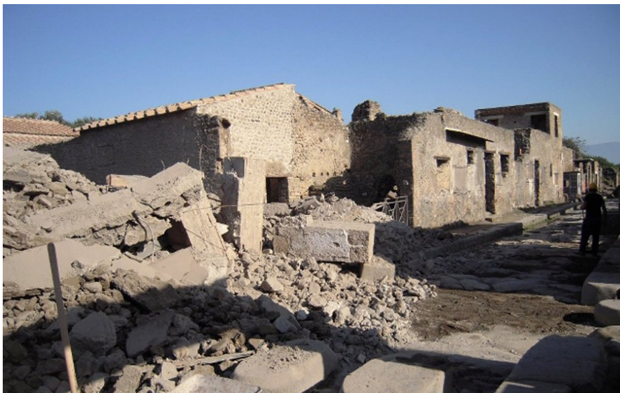
Immagine successiva al crollo della Schola Armaturarum di Pompei: si notino i resti delle strutture in c. a.
