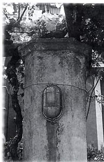
La lampada posizionata per aiutare la sommità della colonna.
