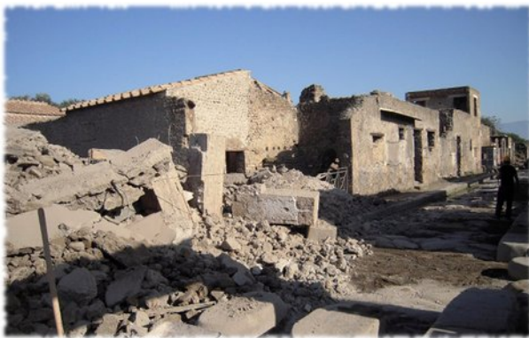
Crollo Schola Armaturarum.
