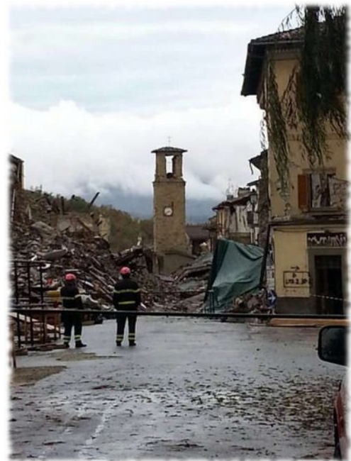
Amatrice. La torre civica sopravvissuta a tutte le scosse. Sulla sinistra si vedono le macerie del crollo dell'edificio rosso.
