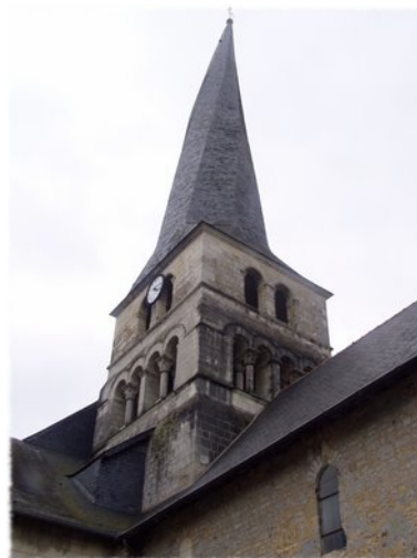
Il tipico campanile della chiesa di La Vieil Baugé.
